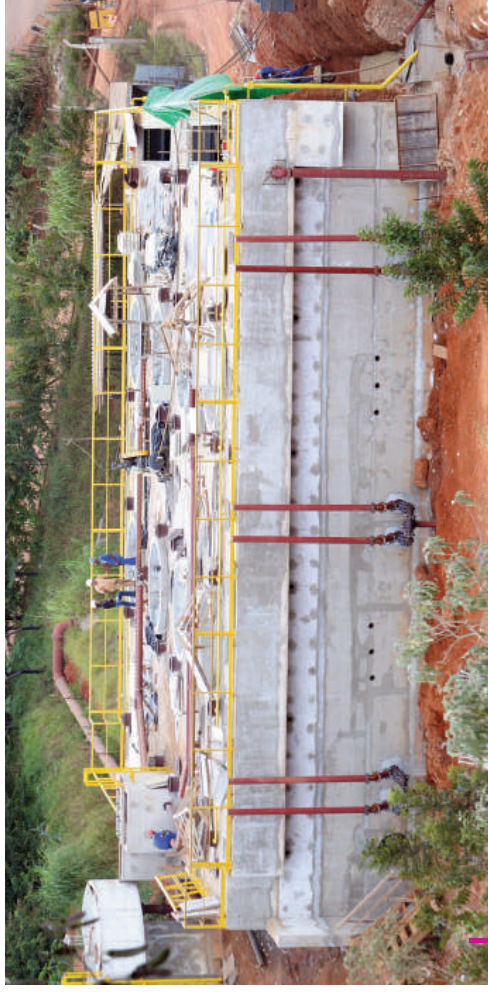
Estação de tratamento de esgotos vai beneficiar a população local
