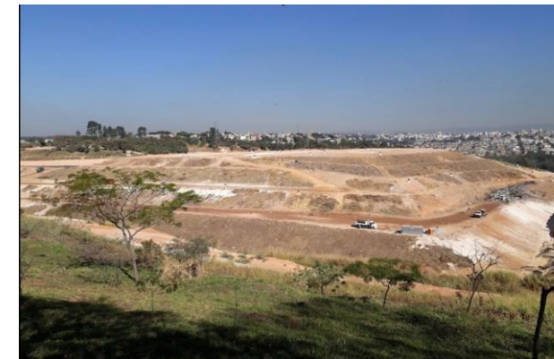
Aterro Sanitário – Bairro Perobas
